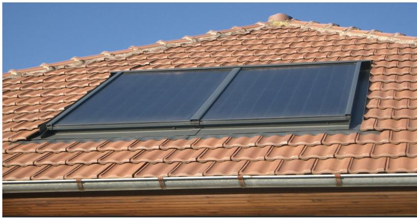
Les rayons du soleil, piégés par des capteurs thermiques vitrés, transmettent leur énergie (énergie solaire) à des absorbeurs métalliques – lesquels réchauffent un réseau de tuyaux de cuivre où circule un fluide caloporteur. Cet échangeur chauffe à son tour l'eau stockée dans un cumulus. Un chauffe-eau solaire produit de l'eau chaude sanitaire ou du chauffage généralement diffusé par un « plancher solaire direct ».
